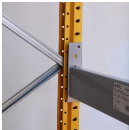
Figura 3. Conexão dos contraventamentos e da longarina com a coluna.[3]
