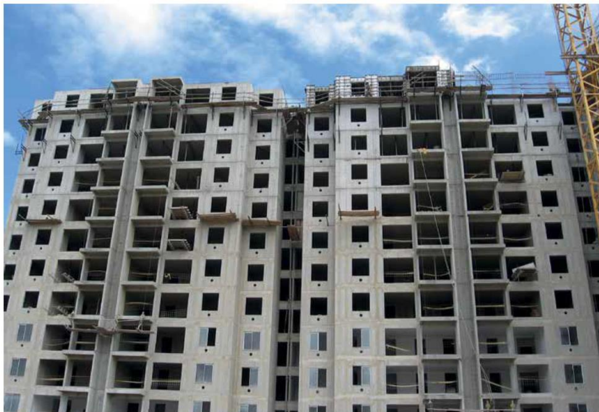
Figura 1. Edifício de paredes de concreto moldadas no local. Testoni e Correa [12]
