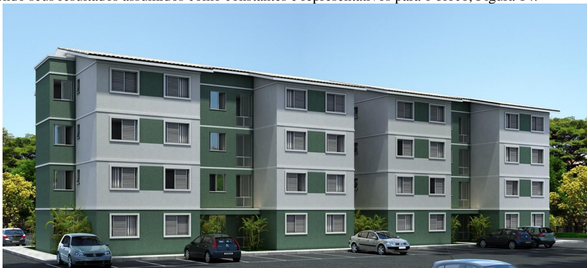
Figura 13. Edifício piloto em paredes de concreto.
