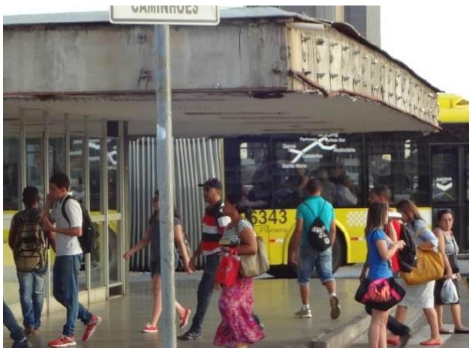
Figura 7. Detalhe de um dos vértices da marquise: Autores
