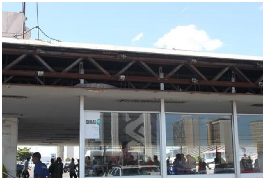
Figura 8. Detalhe de um reparo feito na marquise da Plataforma Superior da Rodoviária do Plano Piloto com a substituição das vigas em concreto por treliças metálicas: Autores
