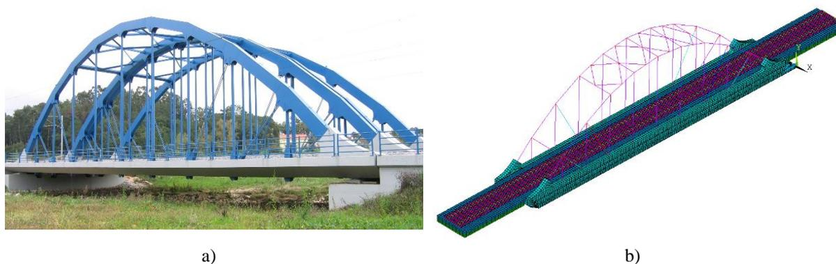
Figura 2. Ponte ferroviária de São Lourenço: a) visão geral, b) modelo em elementos finitos
