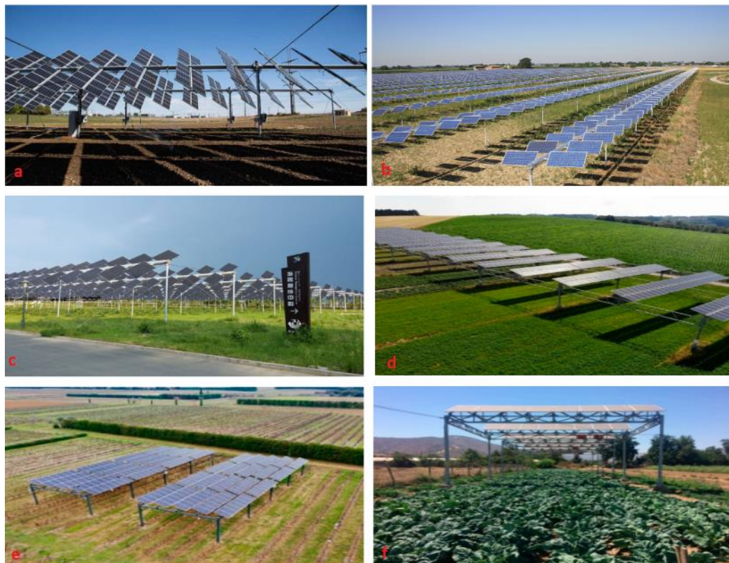
Figure 1. Commercial and research plants (a) Les Renardieres/France* (b) Castelvetro/Italy* (c) Jinzhai/China* (d) Heggelsbach/Germany** (e) Pionlec/France* (f) Curacaví/Chile**. * © Fraunhofer ISE ** © REM Tec.
