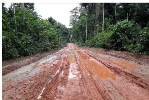
Figura 4 - Estrada com excesso de erosões causadas pela chuva e tráfego de caminhões.
